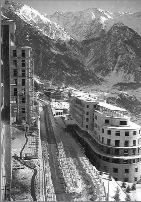
Fig. 1.14 - VILLAGGIO SANATORIALE MORELLI IN COSTRUZIONE.
